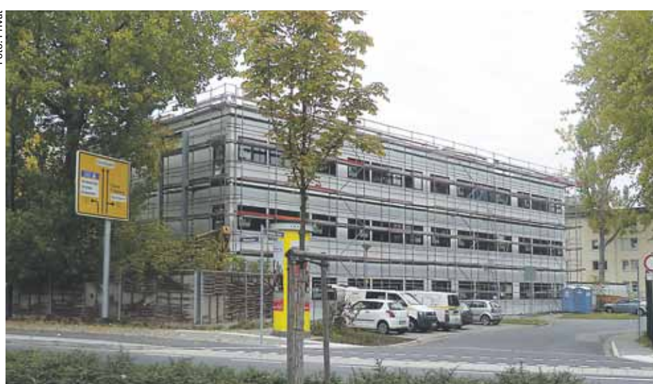
Noch mit Baugerüst – Ende des Jahres soll der Seminarpavillon fertig sein.
